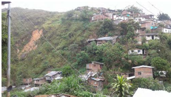
Figura 1. Viviendas sobre la quebrada Isabel Pérez en la Comuna 20, Cali, Colombia
