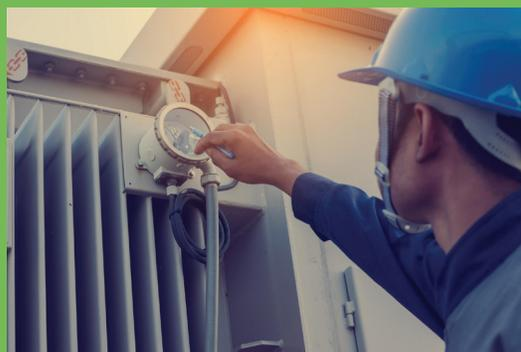
En el caso de una falla severa, la generación súbita de gases causa movimientos de aceite y gas en el tubo que interconecta al transformador con el tanque conservador y también en el relevador Buchholz, accionándose un segundo mecanismo que opera un segundo switch de mercurio que manda una señal de disparo.
