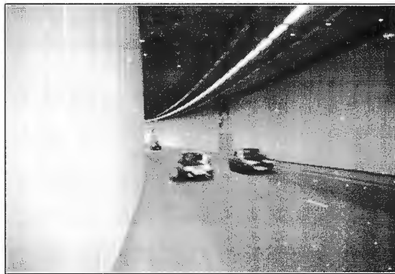
Figura 3.11 - Aplicación de cable radiante en túnel [VI]
