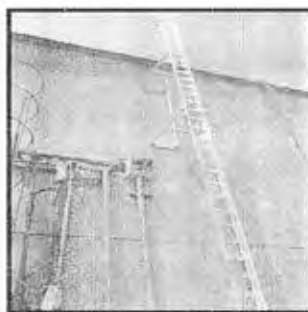
Figura 3.45 - Trayectoria de fibra sobre escalerilla [IX]
