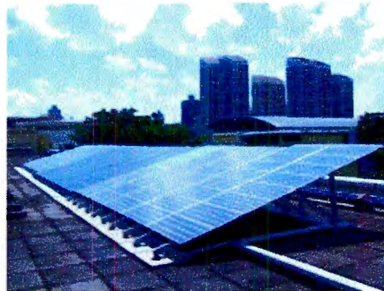
Fig. 7 → Panel solar fijo utilizado para el estudio de la radiación en Singapur [8]
