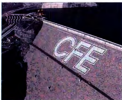
Figura 1. Presa El Cajón, Nayarit [VI]
