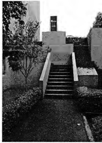
Imagen 11. Acceso al sótano del Mirador
