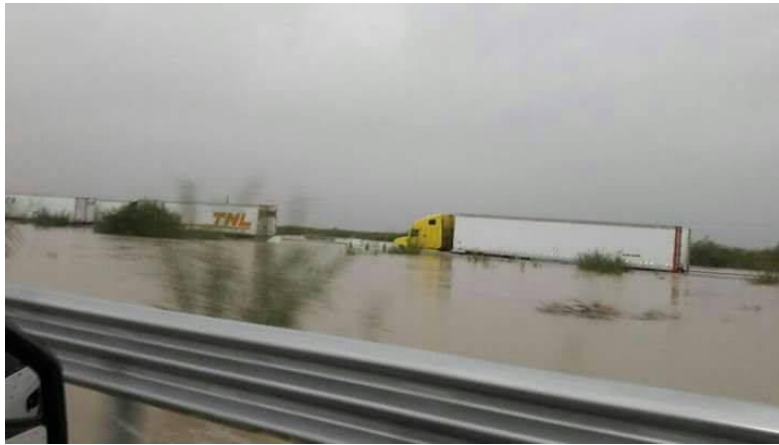
Imagen 4. Autopista Mty-Laredo inundada por lluvias del 28 de septiembre de 2017 I Fuente: anónimo Red social Twitter
