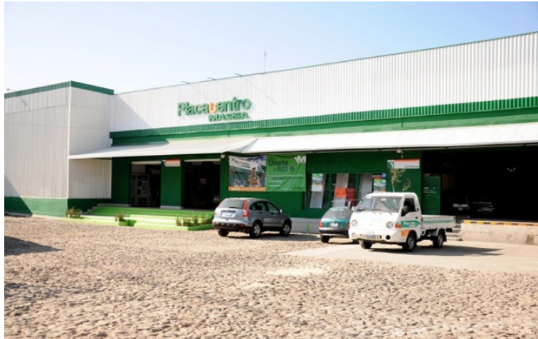
Foto 1.1. Local de Masisa en la calle 5 de febrero, Querétaro, México. Foto proporcionada por la empresa.
