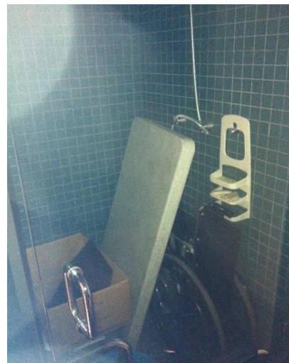
Imagen 4: Regadera de sanitario
