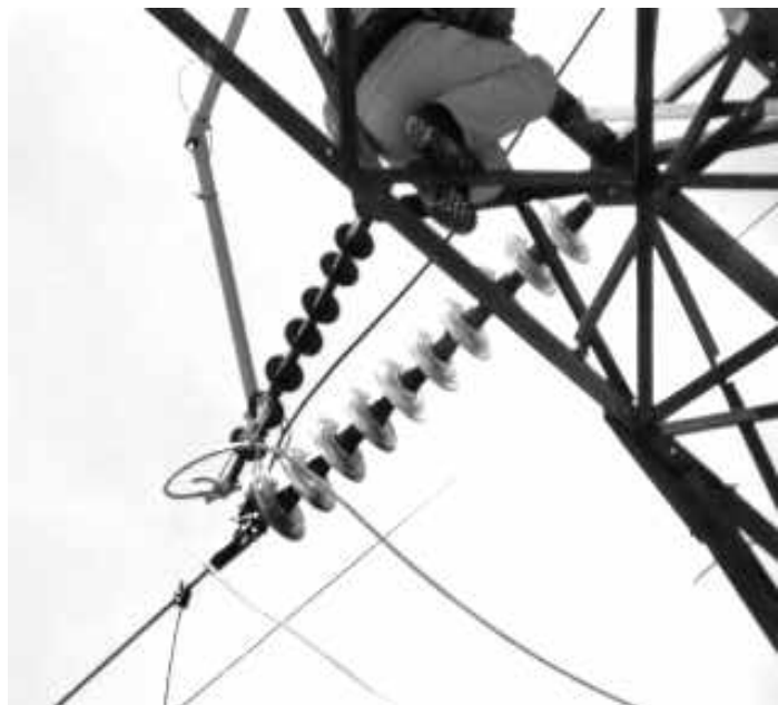
Fig. 1 Forma actual de limpiar los aisladores cerámicos
