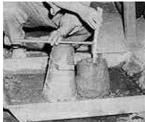
Figura 1. Prueba de Revenimiento, Medido a 4 cm para Todas las Mezclas.
