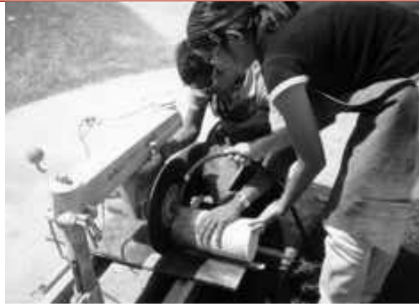
Figura 5. Corte del Concreto con Disco.
