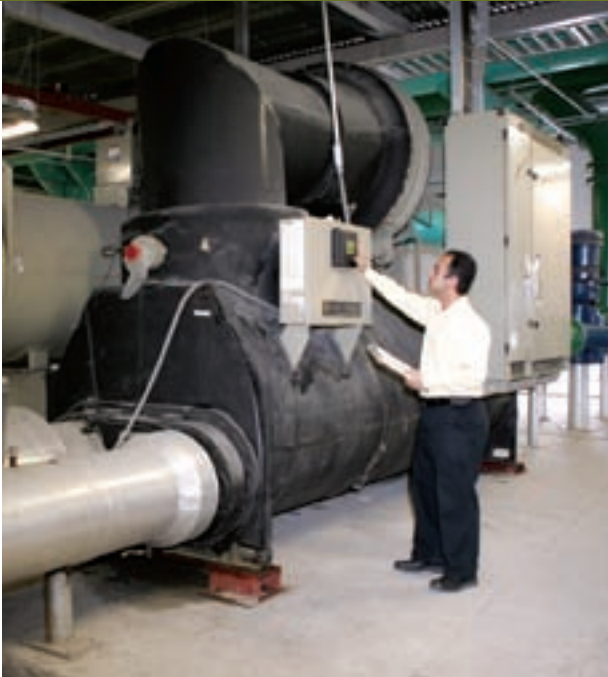
Revisión y mantenimiento de equipos.
