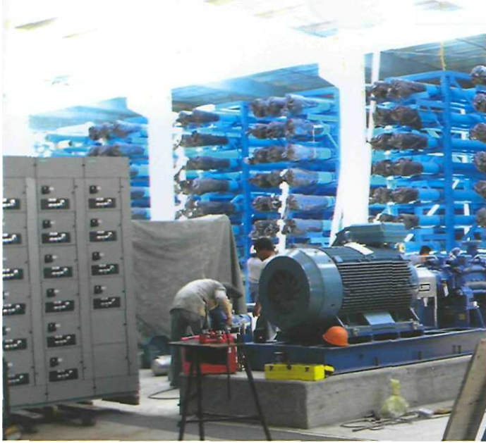
Planta Desaladora en Proceso de Construcción Cabo San Lucas, B.C.S., México
