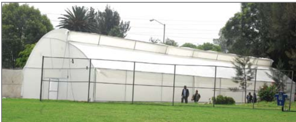
>Invernadero hidropónico ubicado en el Centro Cultural y Deportivo
