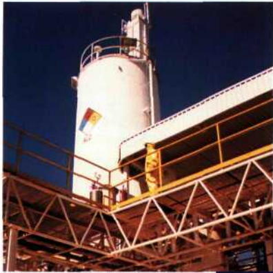
Planta de Neutralización, Mina, N.L.
