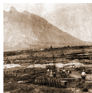
1945 - En el mes de junio inician las obras de construcción del Campus Monterrey
