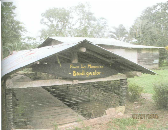
Foto 7: Biodigestor para el tratamiento de excretas
