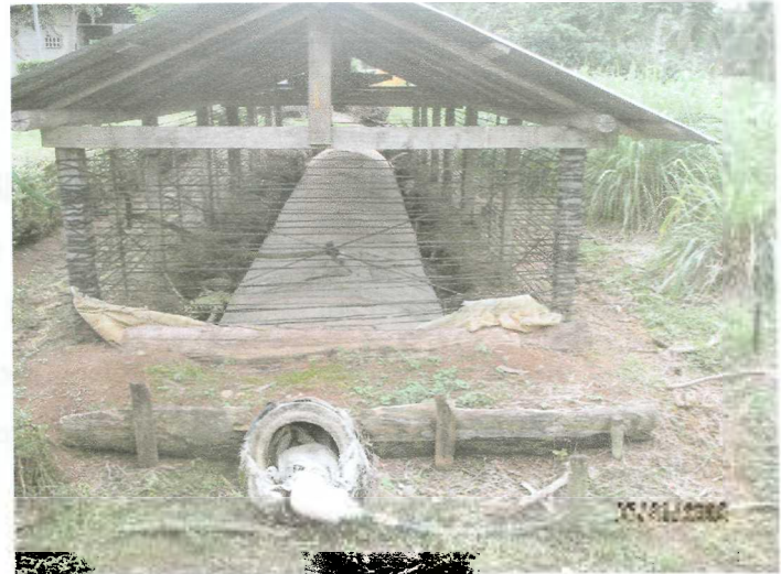
Foto 8: Utilización del biogas generado en el biodigestor
