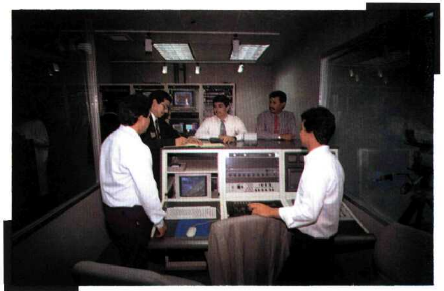
Cabina de control del SEIS
