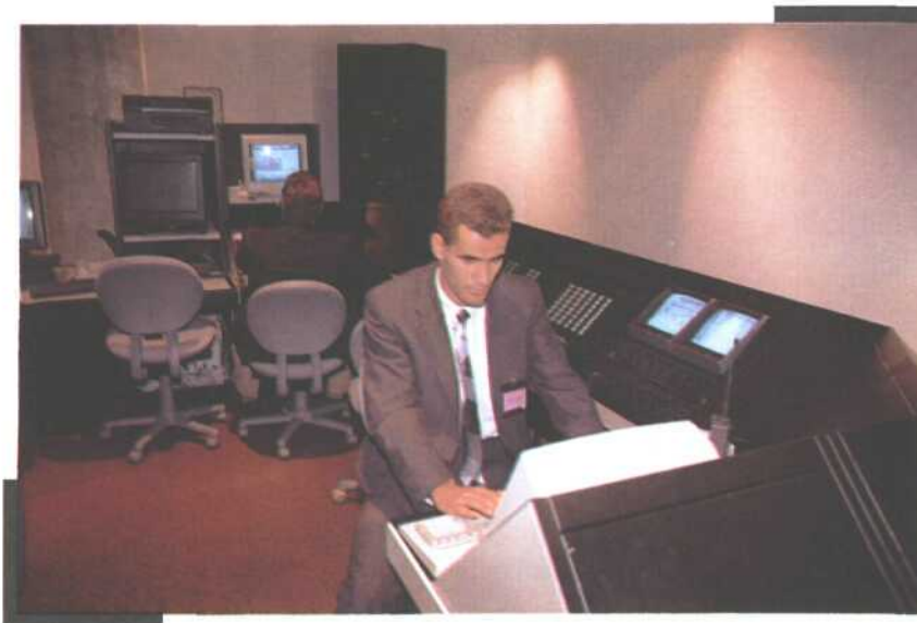
Cabina de control inteligente del edificio
