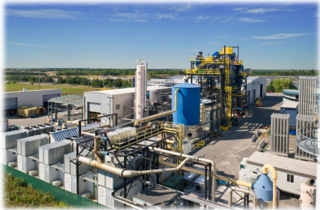
Foto 5.1. Planta Piloto de Gasificación por arco de plasma para conversión a Energía (Proyecto Plasco Trail Road)
