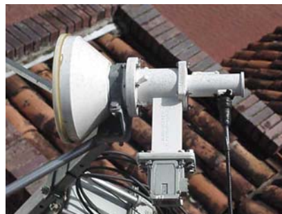
Figura 9. Configuración del Alimentador (cabezal) y LNC.
