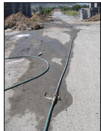
**Figura 4: Derrame excesivo de agua por el curado**
