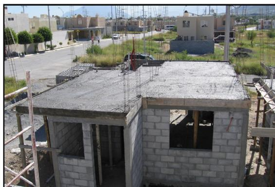
Figura 9: Losa de concreto recién colada con concreto premezclado
