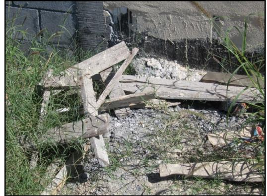
**Figura 16: Pedacería de madera producto del corte para adaptar las dimensiones de la cimbra**
