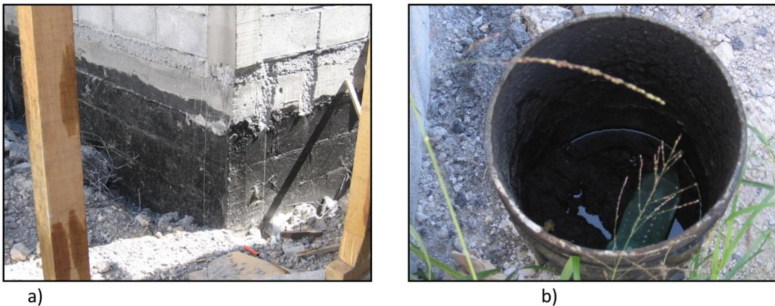
**Figura 11: a) Emulsión asfáltica colocada para evitar la filtración de agua al interior del relleno de la casa. b) desperdicio del impermeabilizante depositado en un contenedor inapropiado y tirado en el sitio de la obra.**
