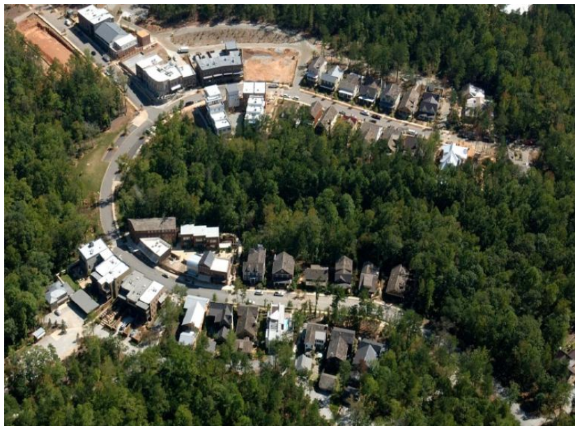
Figura 17: Fotografía del sitio.
