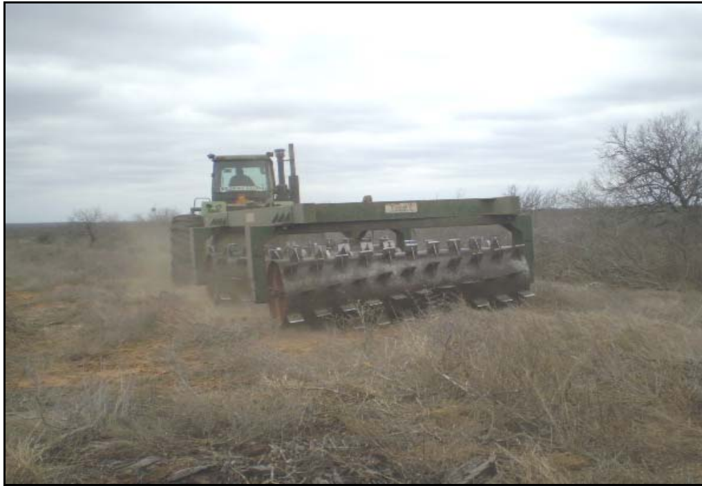
Figura 22. Paso del rodillo aireador por una parcela de tratamiento. Demostración experimental conforme a la metodología aplicada como parte del Proyecto de Restauración de Ecosistemas de Pronatura Noreste A. C. en el Rancho Rosita, Anahuac. N. L.
