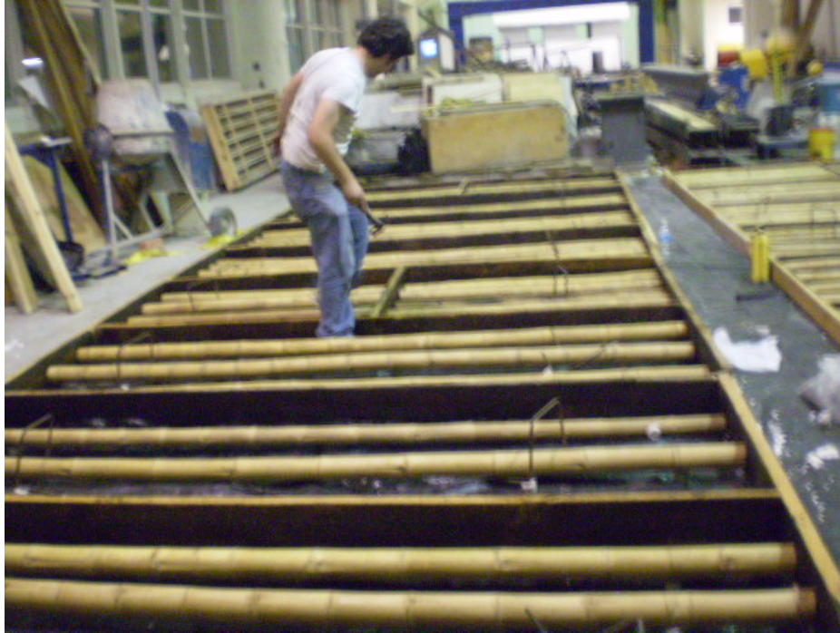
Foto 6.3. Colocación del bambú dentro de las cimbras, manteniendo el recubrimiento propuesto.
