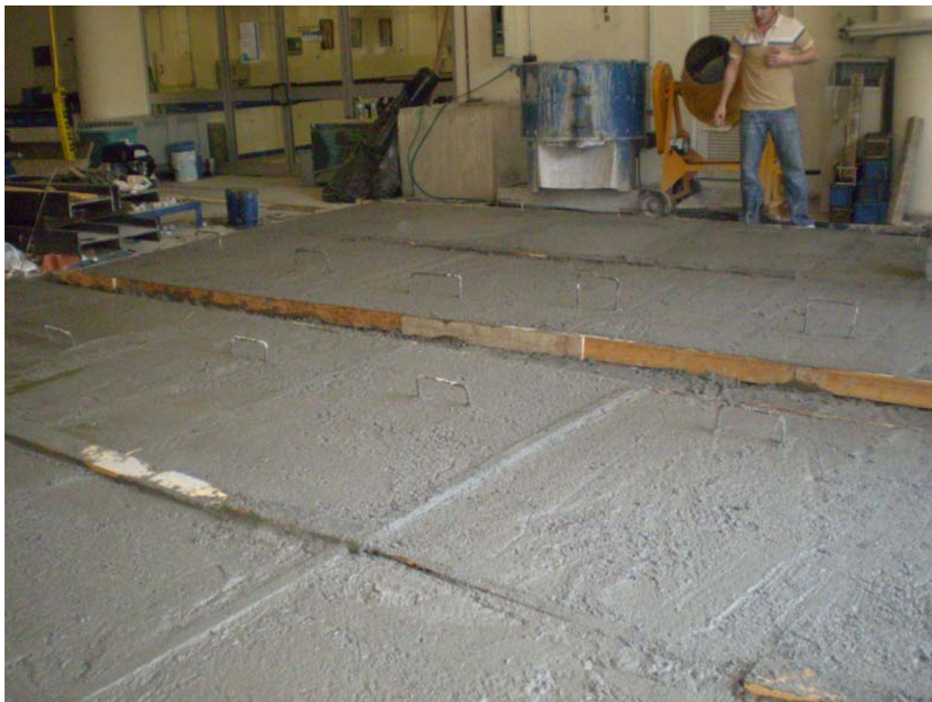
Foto 6.5. Colado de las losas.
