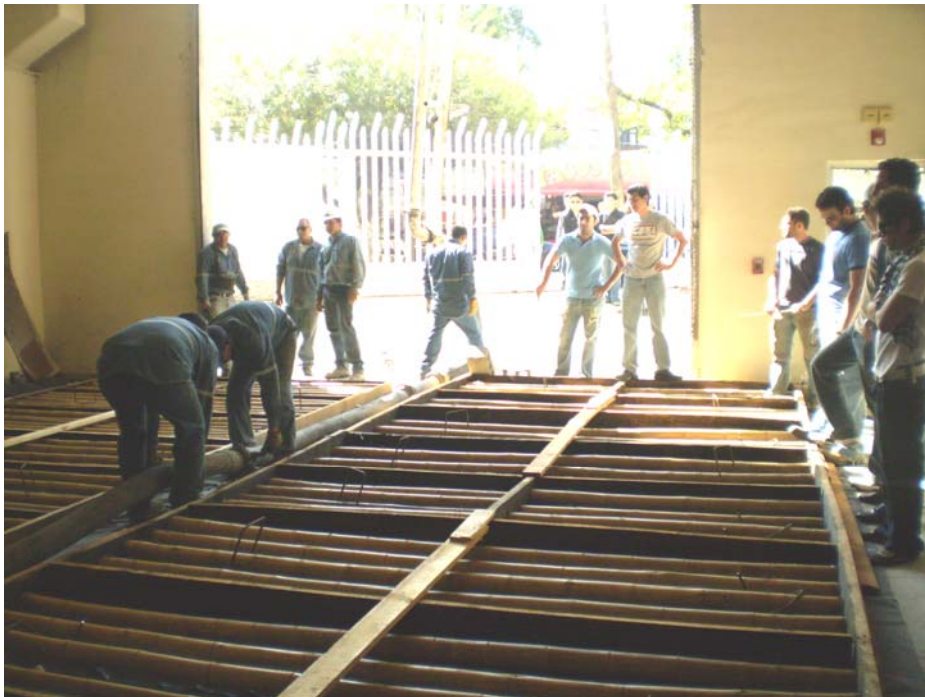
Foto 6.4. Colocación de las mangueras de bombeo para el colado del concreto.
