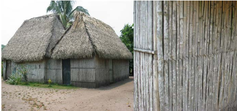
Foto 2.2. Viviendas Construidas con bambú ( Guadua Velutina ) en Huamanguillo, Tabasco, México
