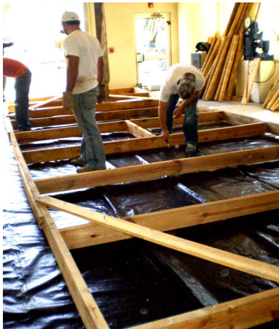
Foto 6.2. Colocación y nivelación de la cimbra.
