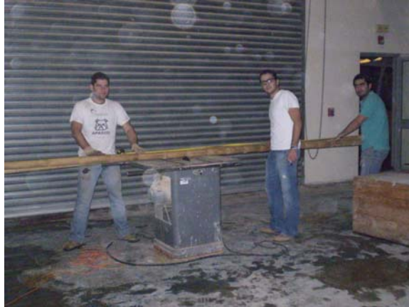
Foto 6.1. Corte de las piezas de Bambú para ser colocadas como refuerzo a flexión en las losas
