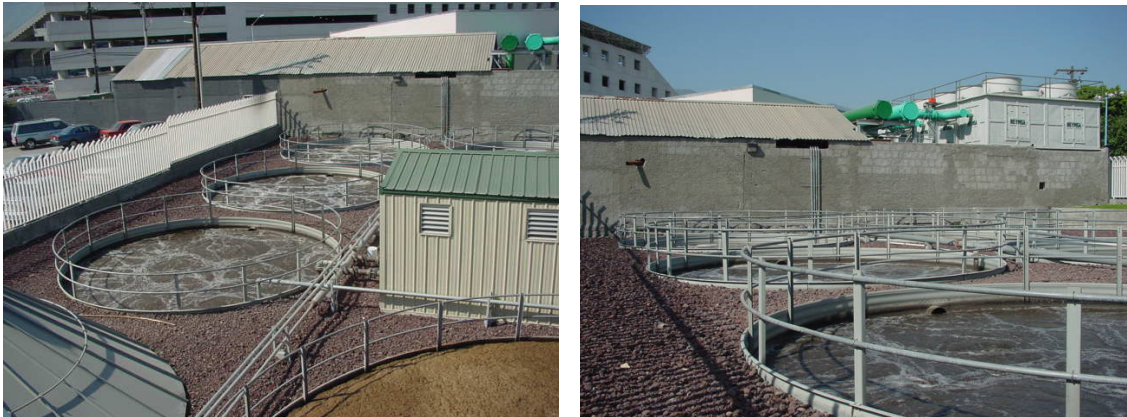
a) b) Figura 3.1. a) Vista panorámica de la planta de tratamiento de agua del ITESM; b) Sistema de biorreactores en serie.
