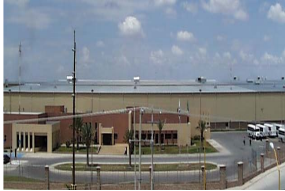
Figure AP. 4.2 Caterpillar Torreon S. de R.L (CATO)
