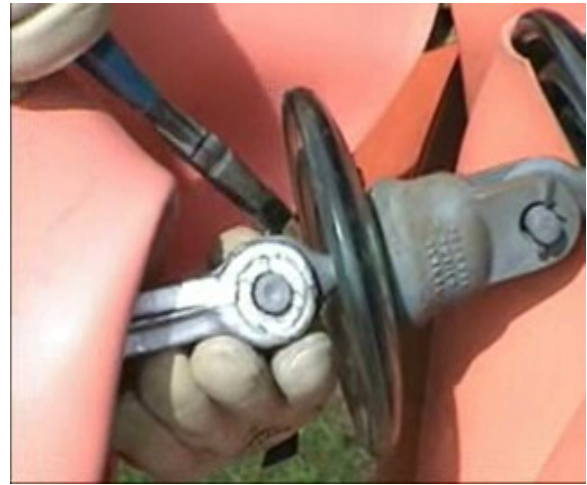
Figura 4. 7 Cambio de aislador (paso 28).
