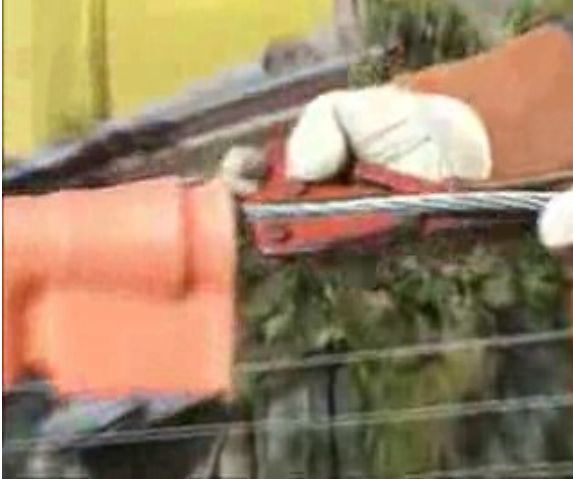
Figura 4. 6 Instalar tensor (paso24).
