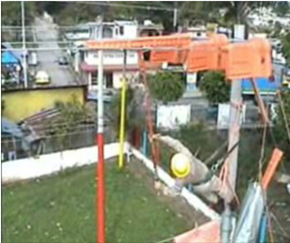
Figura 4. 3 Instalación de protectores de línea (paso 14).
