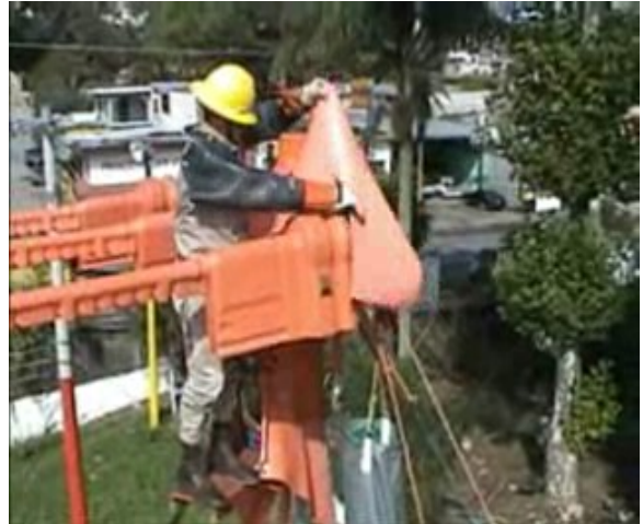
Figura 4. 5 Cubrir puntos de referencia a tierra (paso 19).
