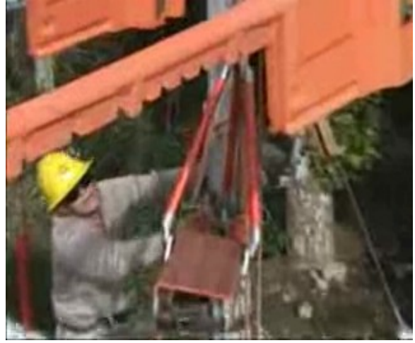
Figura 4. 4 Instalación de plataforma (paso 15).
