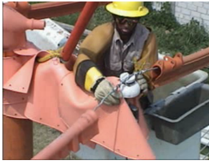
Figura 1.3 Cambio de aislador tipo alfiler (Tomado de CFE, 2004)
