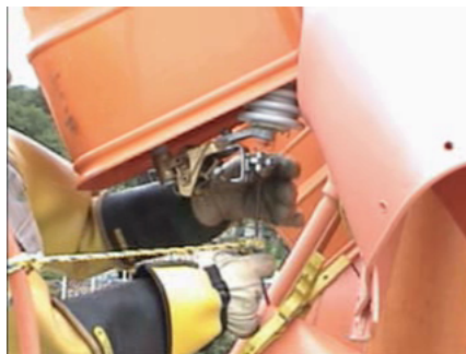
Figura 1. 2 Cambio de cortacircuito (Tomado de CFE, 2004)
