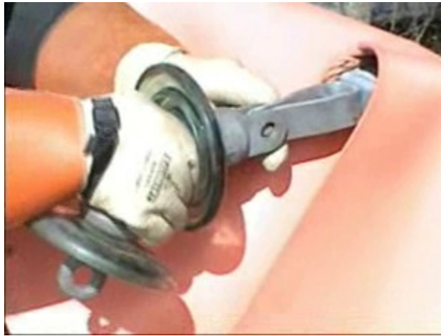
Figura 3. 2 Cambio de los aisladores (Tomado de CFE, 2004)
