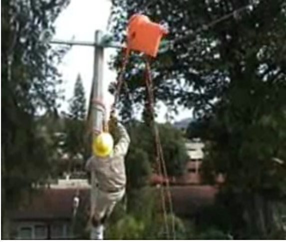
Figura 4. 2 Instalación de protectores de aislador (paso 13).
