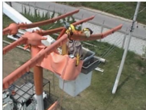
Figura 3. 5 Video de Maniobra “Cambio de aislador tipo alfiler en estructura TS30” (Tomado de CFE, 2004)
