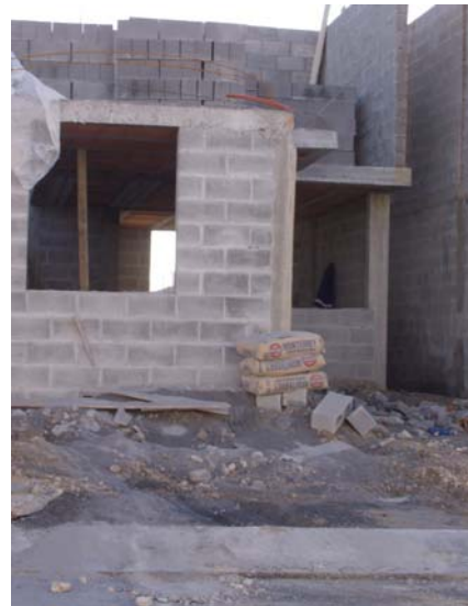
Construcción de muros de block en vivienda (planta alta)
