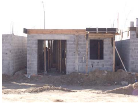
Construcción de Muros de block en vivienda (planta baja)
