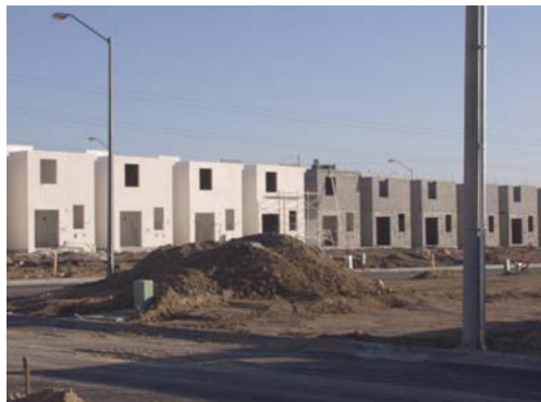
Apariencia de la vivienda aplicado el zarpeo exterior en muros.
