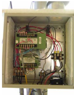
Figura 2.12. Configuración de los transductores de potencia CA y frecuencia.
