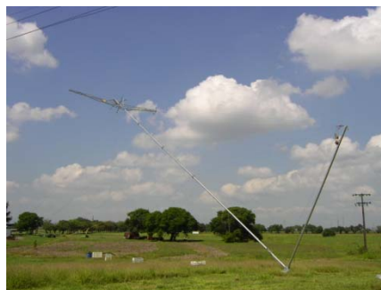
Figura 2.7. Levantamiento de la torre
