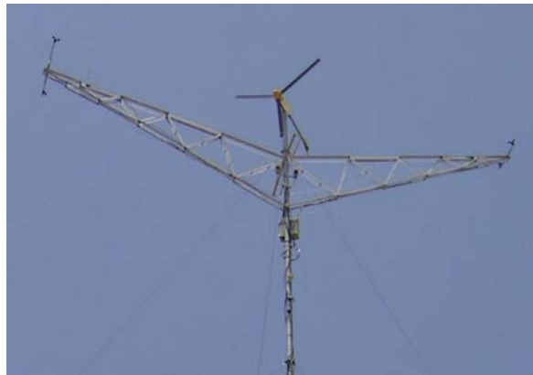
Figura 2.24. Vista de la localización de los sensores
