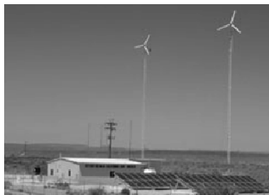
Figura 1.1. Sistema híbrido solar- eoloeléctrico
