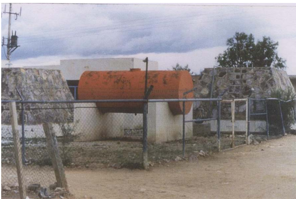
Figura 3: Se puede observar lo que queda de la planta construida en el ejido Tanque de Aceros, puede apreciarse un pequeño cuarto de adobe donde tenían alojada la unidad de ósmosis inversa. Municipio de Mazapil, Zacatecas.
