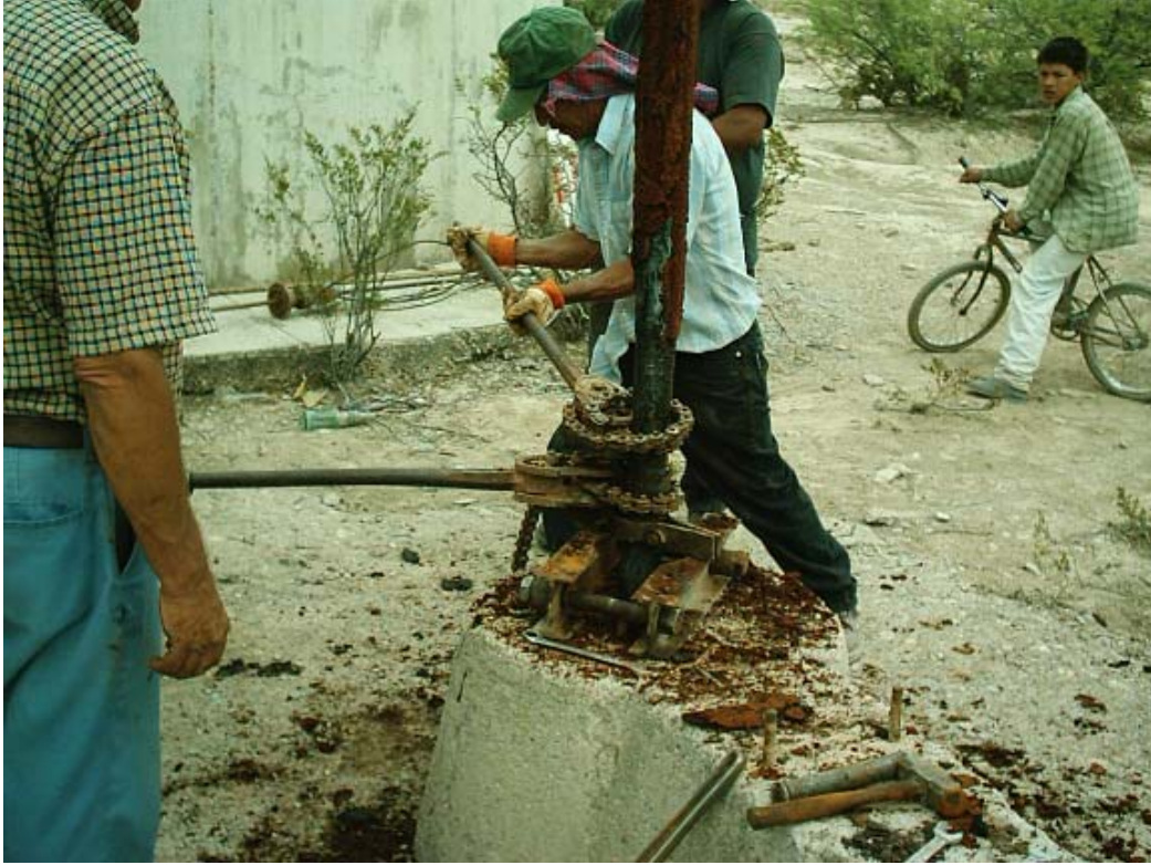
Foto 2: Extracción de la tubería oxidada del pozo
