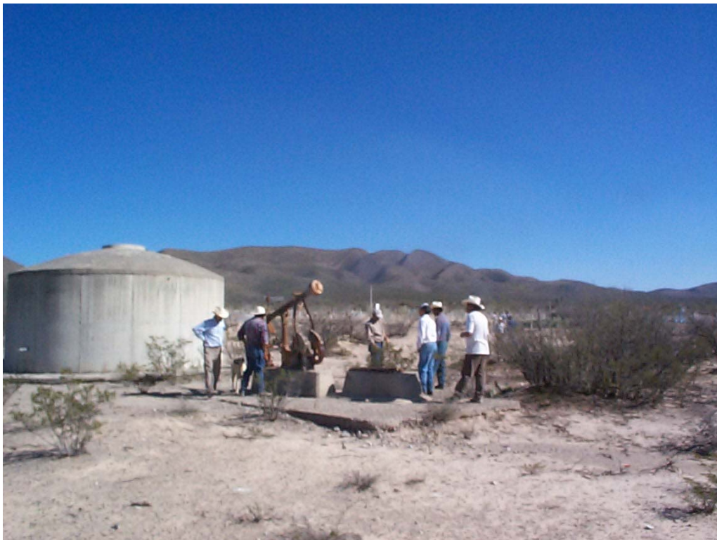
Foto 1: Pozo con tanque de 50,000 litros
