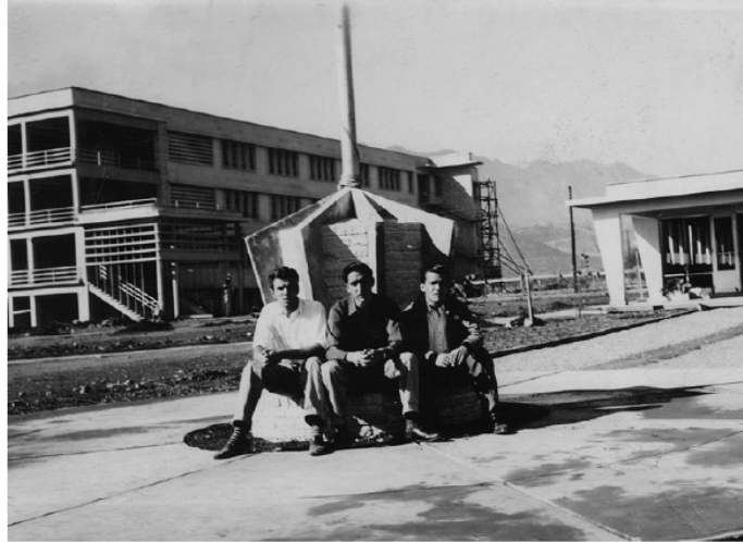
Alumnos posando en la base de lo que entonces era el asta bandera. Al fondo, la cafetería La Carreta y la primera sección de Aulas II.
