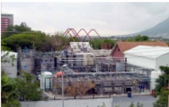
Fig. 1.- Planta de Demostración del proceso de biolixiviación en Peñoles Monterrey, muestra al fondo los bioreactores y las etapas de filtración y neutralización; al frente el circuito de extracción por solventes.
