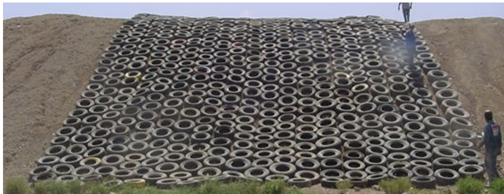
Figura 3. Hileras de llantas previo a ser rellenas con tierra
