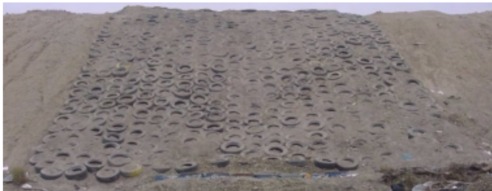
Figura 4. Hileras de llantas rellenas con tierra
