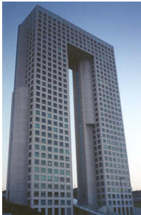
Foto 3 “Torre Arcos Bosques”
