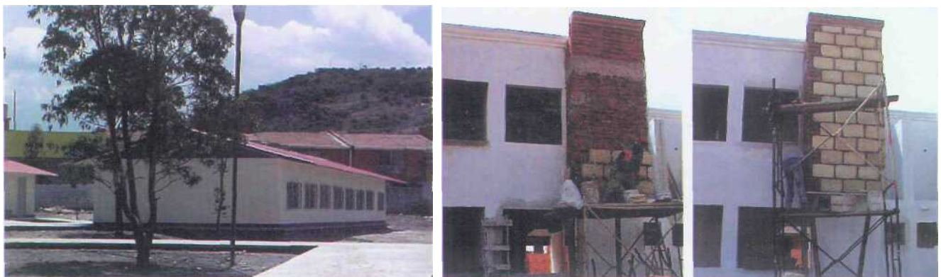
FIGURA 2 Construcción de vivienda urbana con mortero de anhidrita.
