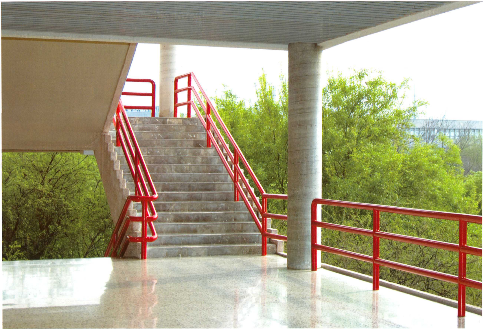
Pasillo de Aulas VI
