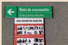
>señalización de evacuación
