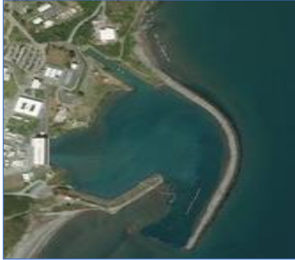
Figura 4.2: Escolleras de la CNLV.
