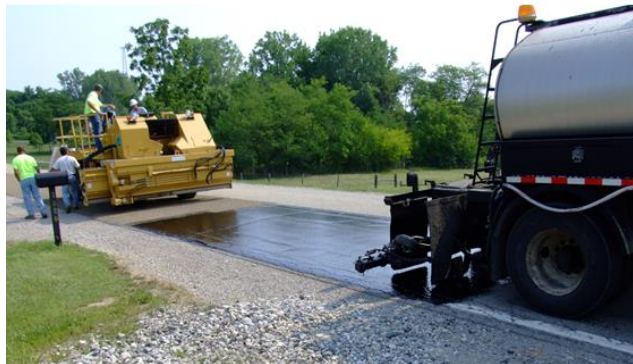
Figura. 2.8 Colocación de Chip Seal.
