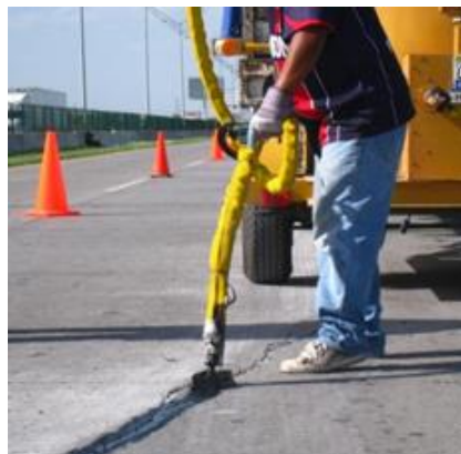
Figura. 2.9 Sellado de Grietas
