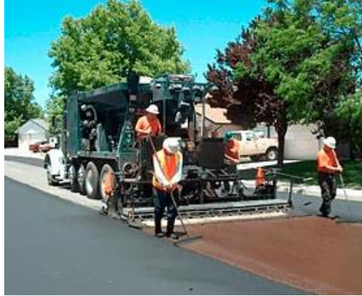
Figura. 2.7 Colocación de Slurry Seal.
