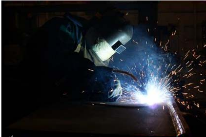
Figura 8. Aplicación de soldadura
