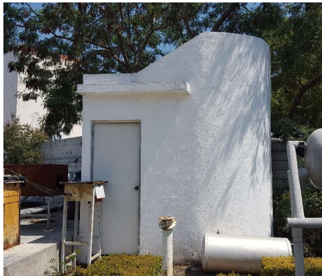
Figura 5.1. Cuarto de monitoreo- Casa Solar ITESM, campus MTY.
