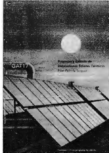
colector transmite calor por convección al aire del exterior, por conducción a las partes frías que se encuentran en el mismo colector, así como por radiación infrarroja (entre los 8 y 10  $\mu$  en el infrarrojo). De esta forma se reducen éstas pérdidas con la colocación de láminas de vidrio o plástico encima de la superficie receptora, creando hermeticidad en el colector.
