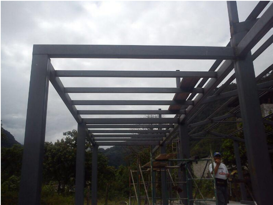
Fotografía 3: Centro del Adulto Mayor Estructura Metálica 1
