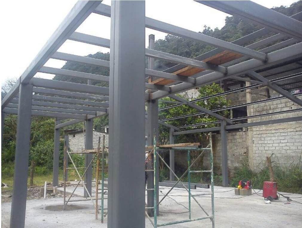
Fotografía 4: Centro del Adulto Mayor Estructura Metálica 2
