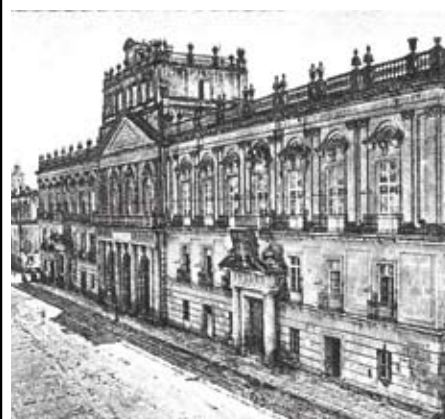
EXTERIOR E INTERIOR DEL PALACIO DE MINERÍA
