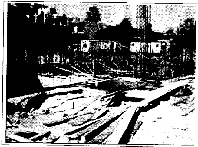
Figura 11: Congestionamiento de la obra.
