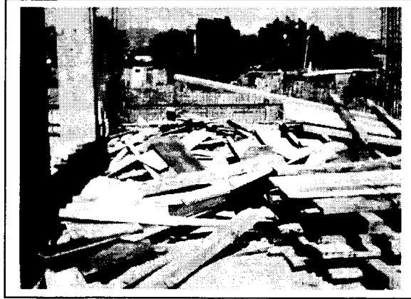
Figura 7: Congestionamiento de la obra.
