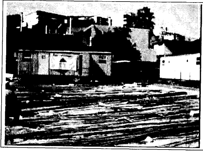
Figura 10: Congestionamiento de la obra.
