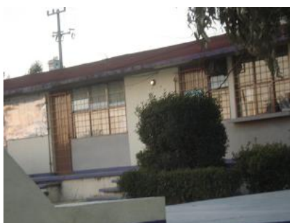
Figura 5. Instalaciones Telesecundaria B
