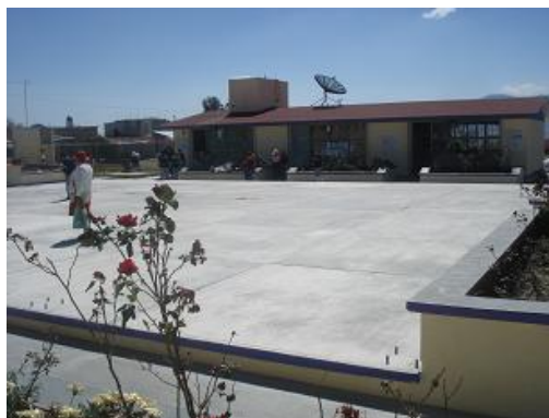
Figura 4. Instalaciones Telesecundaria A
