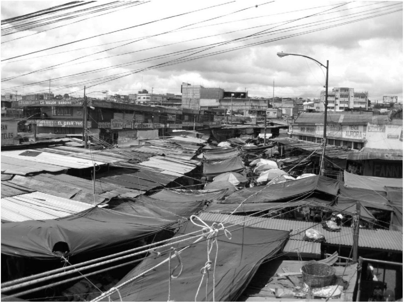
Fig. 58 Mercado "La Terminal", Guatemala, 2009 - En la ciudad informal, la estructura rígida y fija -lo formal- siempre es efímera, mientras que las estructuras dinámicas, adaptables y repetibles -"lo informal"- es siempre duradera." Fuente: Propia
