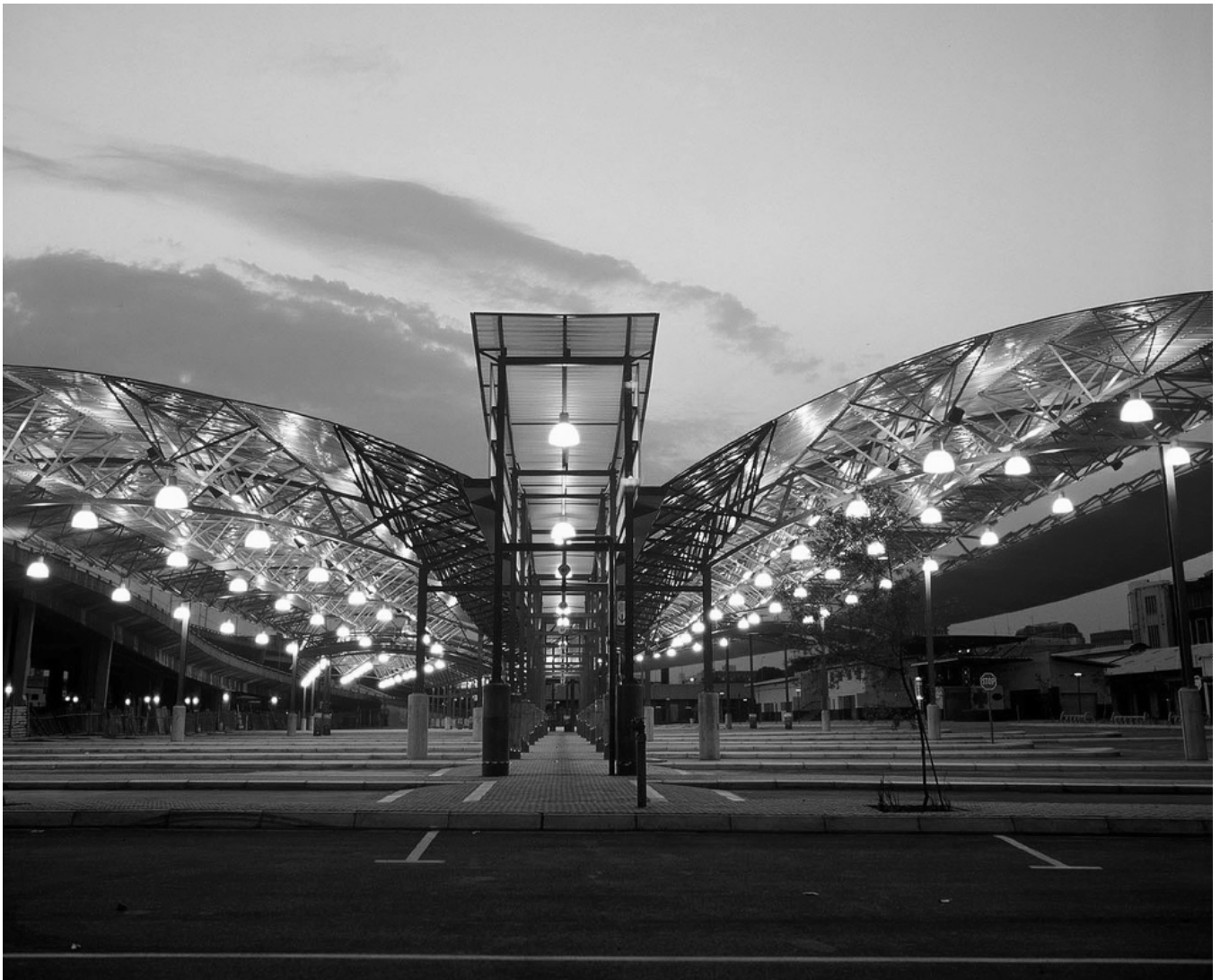
Fig. 36 Terminal Nodal de Buses Faraday, Johannesburgo, 2003 - Hangares de Autobuses Fuente: Municipalidad de Johannesburgo
