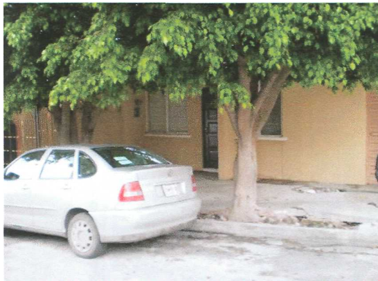
Figura 63. Fachada en buen estado. Fuente: Imagen del autor, 2007.
