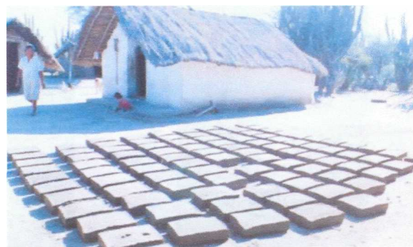
Figura 20. Secado de los bloques de adobe.
