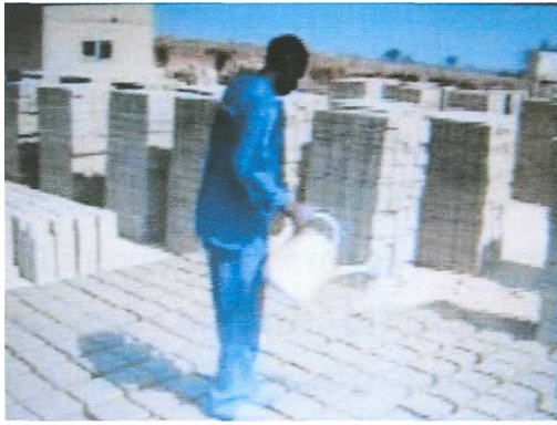
Figura 41. Almacenaje y curado de los BTC Hydraform.
