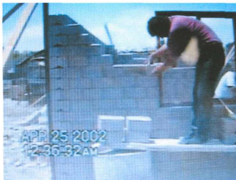
Figura 11. Construcción de una vivienda con bloques Hydraform. Fuente: Video Hydraform, 2002
