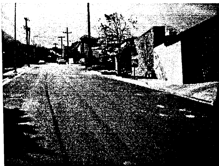
FOTOGRAFÍA 8c. VISTA SUROESTE DESDE LA CALLE DEL FRENTE DE LA CASA.
