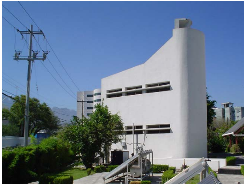
Fig. D.1 Edificio principal del Centro Experimental de Energías Renovables.
