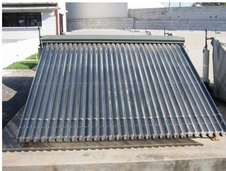
Fig. 1.5 Colector de tubos al vacío de la Casa Solar.
