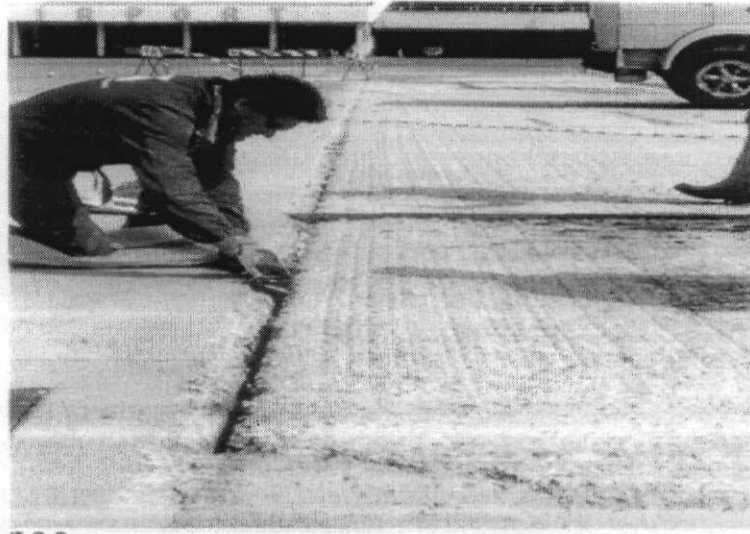
Figura 2.3, grietas superficiales.
